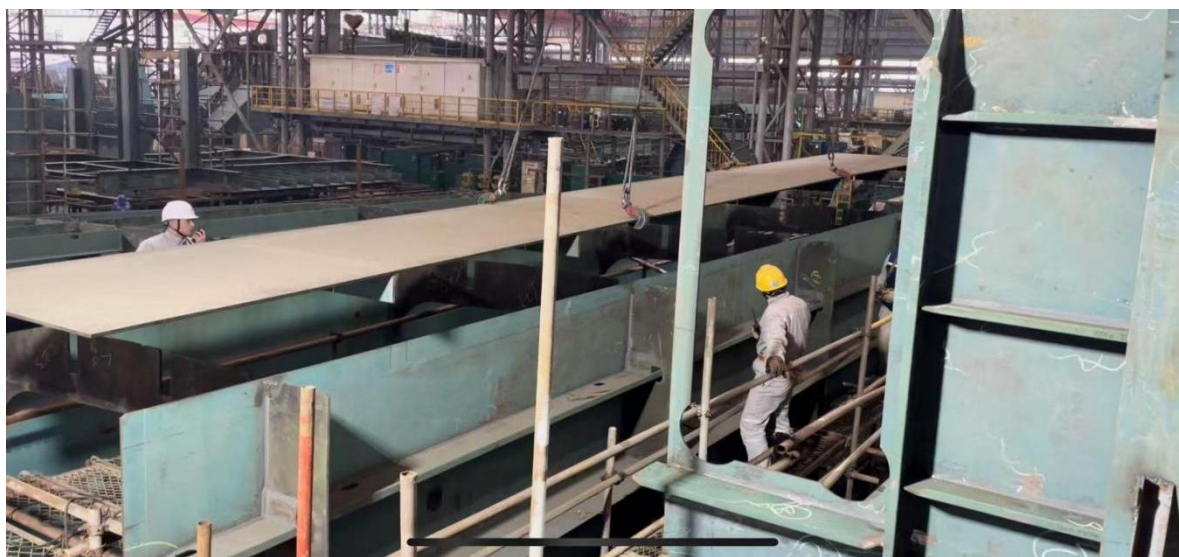
图 4：模拟外板吊装过程
